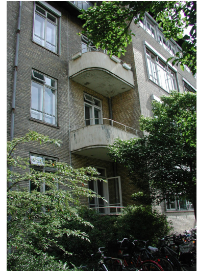
Til venstre: gårdfacade Sindshvilevej 9-9A. Her har det været muligt at etablere tagaltaner oven på køkken-trappetrappene. Lige over et eksempel på indpassede altaner med fint rundet hjørne fra Hospitalet Bygning 10.
