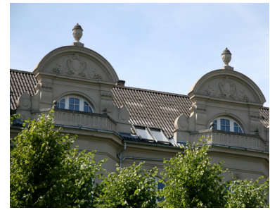
Markante karnappartier med altaner på toppen fra Frederiksberg Allé 19A.
